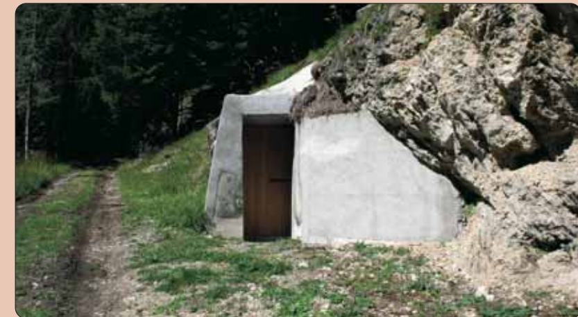
Casermetta prima di Col Da Daut ristrutturata.
