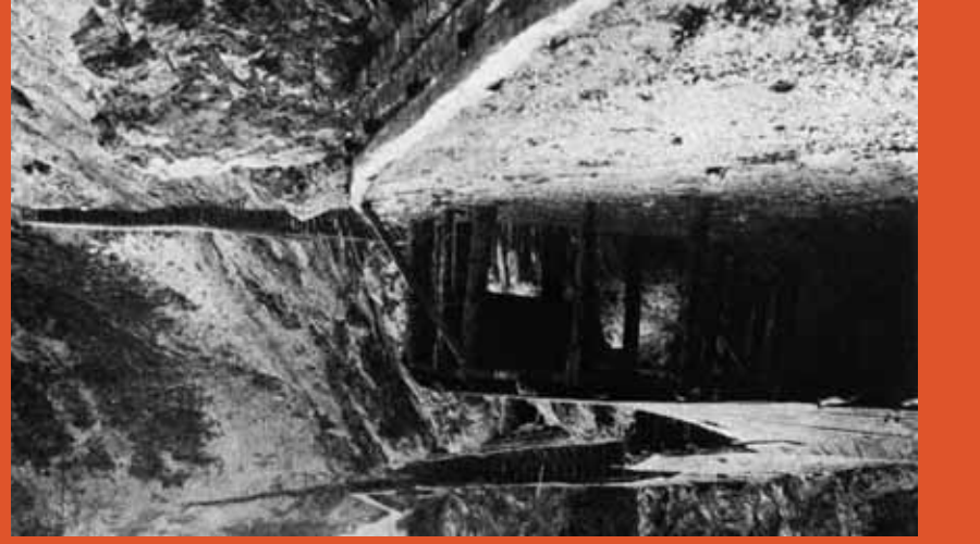
Strada mimetizzata e protetta da tronchi per il Monte Piana, loc. Forcella Alta.
