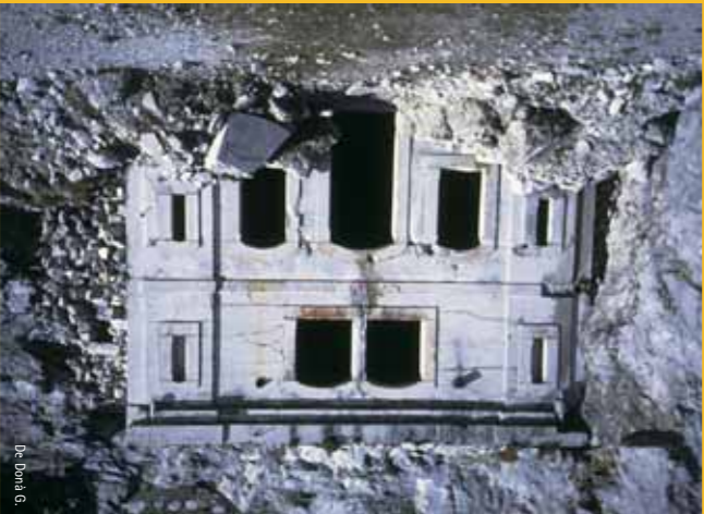
Ingresso del forte e depositi munizioni.
