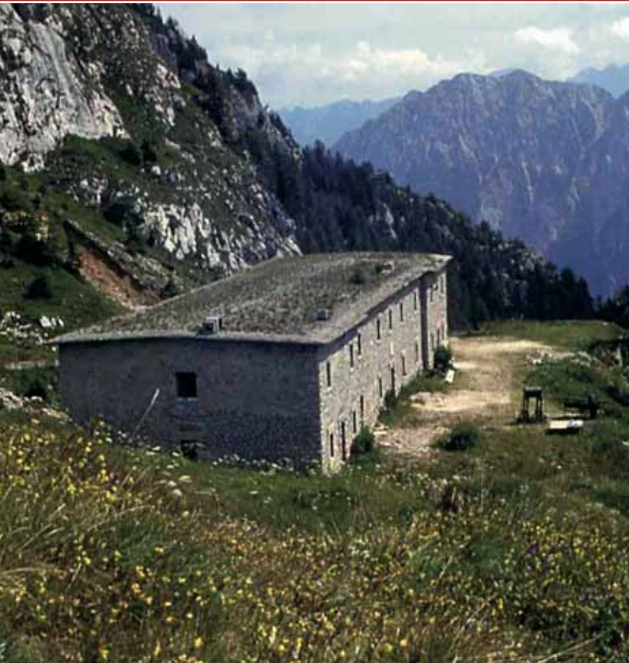
La caserma di quota mt 2013 attualmente in ristrutturazione.
