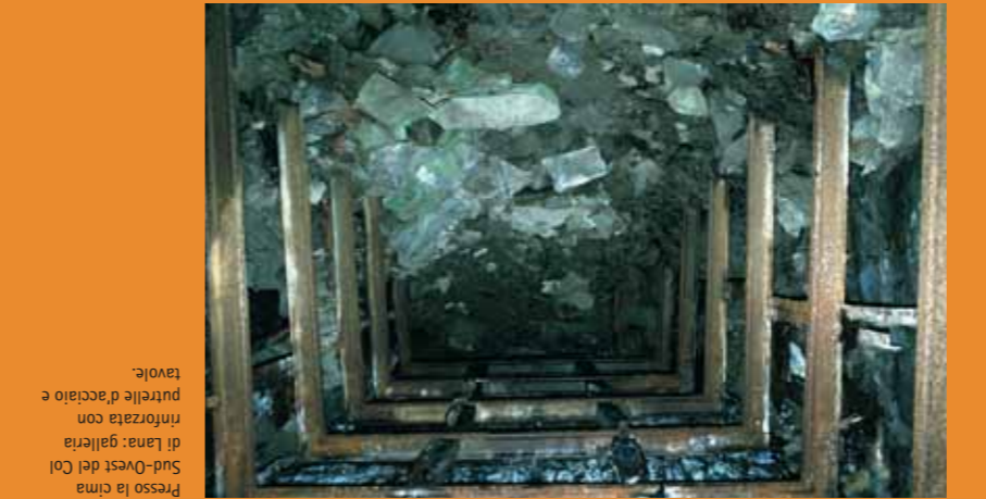
Presso la cima Sid-Ovest del Col di Lana: galleria riforzata con travi di acciaio e tavole.
