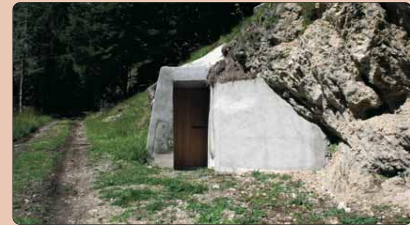
Casermetta prima di Col Da Daut ristrutturata.
