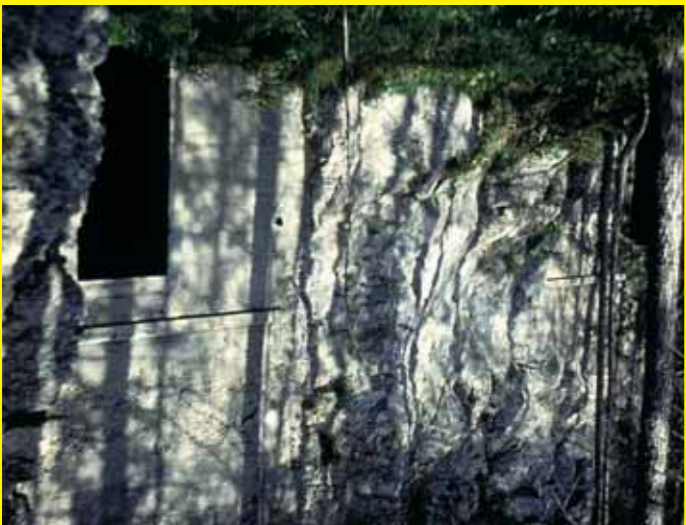
Colpradamio - particolare dell'ingresso in pitrame alla polveriera.
