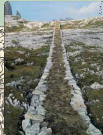
Mulattiera ripristinata. Il percorso conduce a F.lla Lavaredo lungo il costone est del pianoro.
