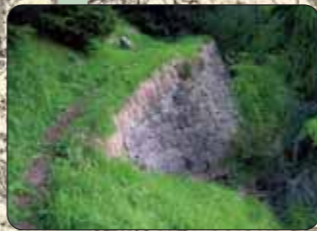
Muro di sottoscarpa strada per Col de Salèra - M. Punta.
