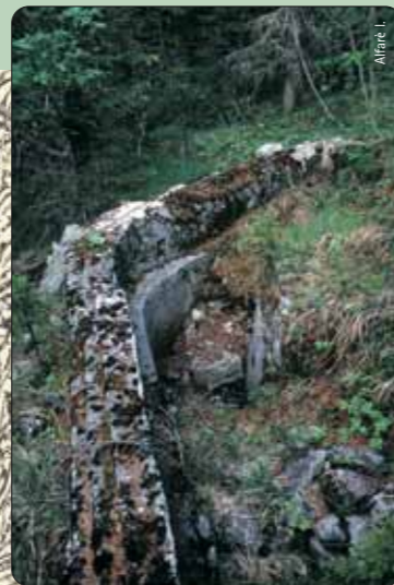
Muraglione di sbarramento in Val Fonda, nei pressi della lapide.
